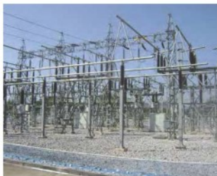
สถานเิกไฟฟ้า
