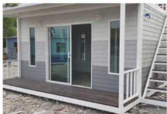
บ้านประกอบเสร็จ
