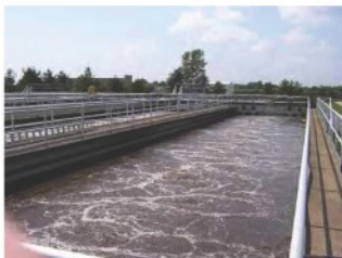
บ่อบำบัดน้ำเสีย
