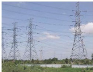
เสาไฟฟ้า
